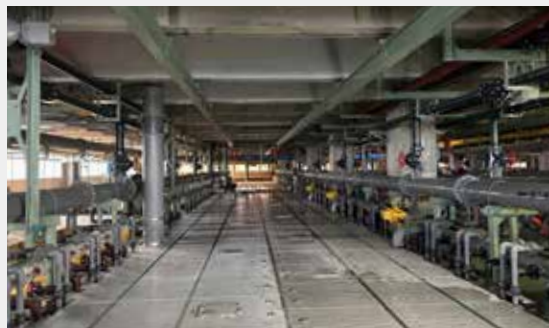
S市B水再生センター
