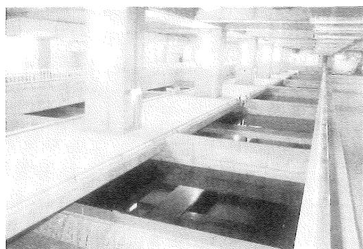
写真4-2 落合処理場 $450,000\text{m}^3/\text{日}$ 急速砂ろ過施設
