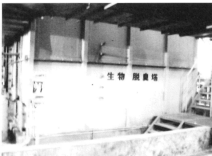
写真7-4 充填塔式生物脱臭装置
