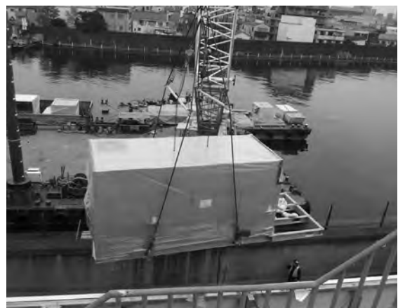
図8-3-5 クレーン船による発電ユニットの搬入
