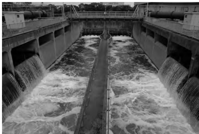
図11-4-6 豊富な水量とある程度一定の落差がある森ヶ崎水再生センター放流口
