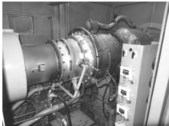
図2-2-4 ガスタービンエンジン掛け立軸斜流ポンプ
