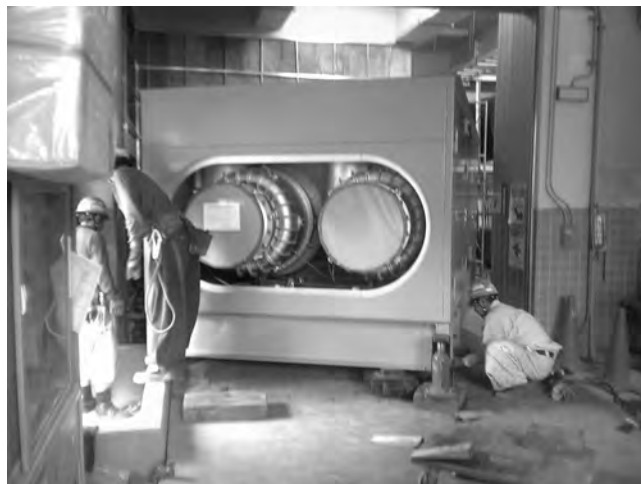
図8-3-1 明石町発電機（3,000 kVA産業用ガスタービン）搬入工事中
