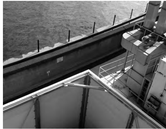
図8-3-7 敷地境界に隣接した防音壁
