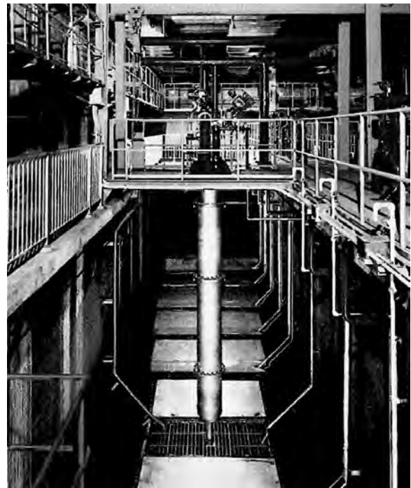
図1-2-3 ジェットポンプ据付例
