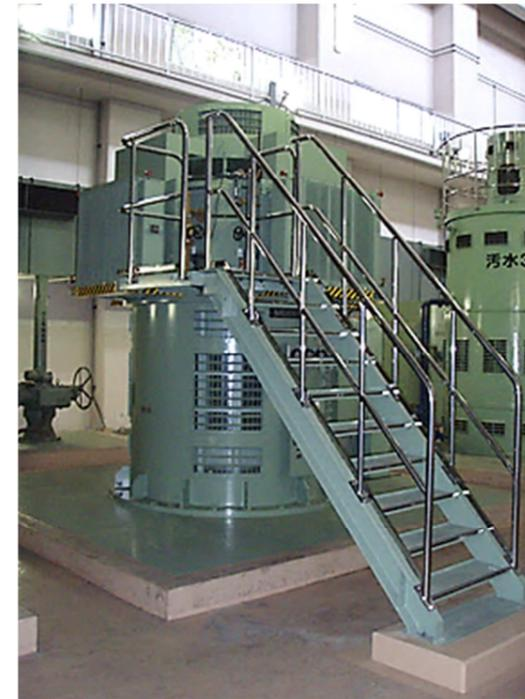
図-3 高圧PMモータ設置状況
