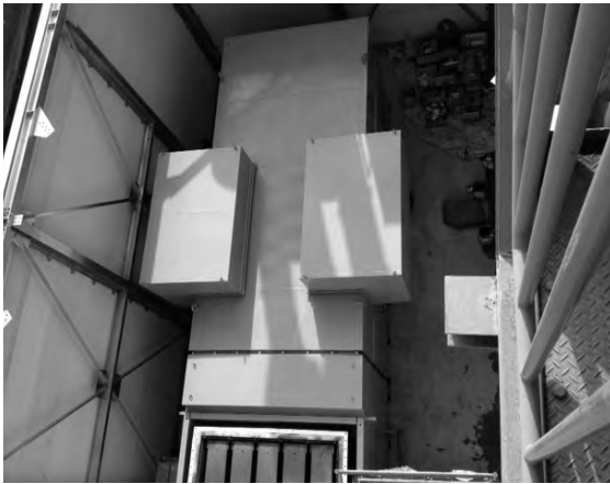
図8-3-6 発電ユニットの設置（排気フード部分が未設置）
