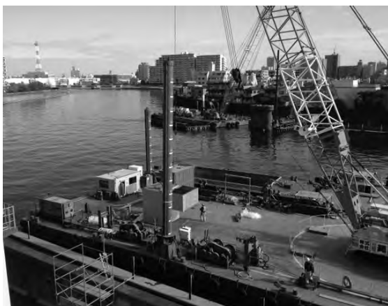
図8-3-4 隅田川台船からの電源ユニットの搬入 (排気フード、燃料タンクが船上)
