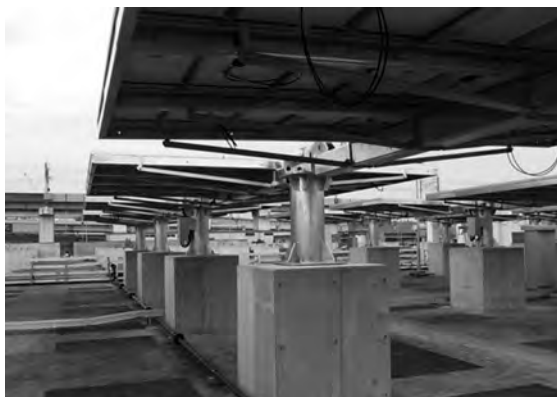
図 11-4-11 「一軸追尾」タイプ水平時
