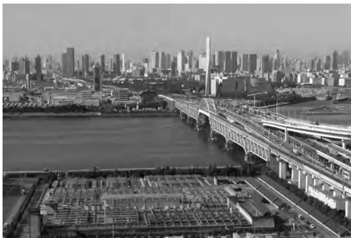
図11-4-7 葛西水再生センター太陽光発電設備
