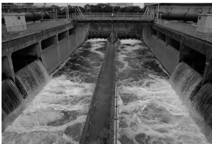
図11-4-6 豊富な水量とある程度一定の落差がある森ヶ崎水再生センター放流口
