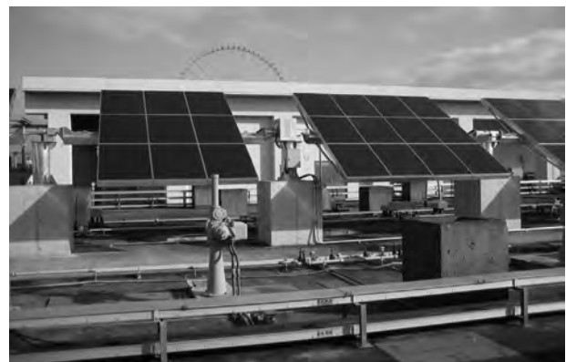
図 11-4-10 「一軸追尾」タイプ傾斜時
