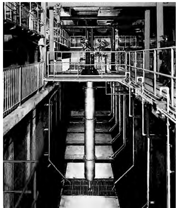
図1-2-3 ジェットポンプ据付例
