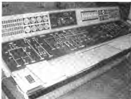
写真9-6 ミニグラフィック盤（加平ポンプ所）
