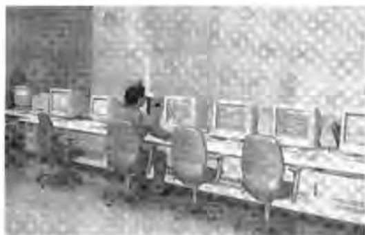
写真9-7 CRTだけの操作卓（両国ポンプ所）
