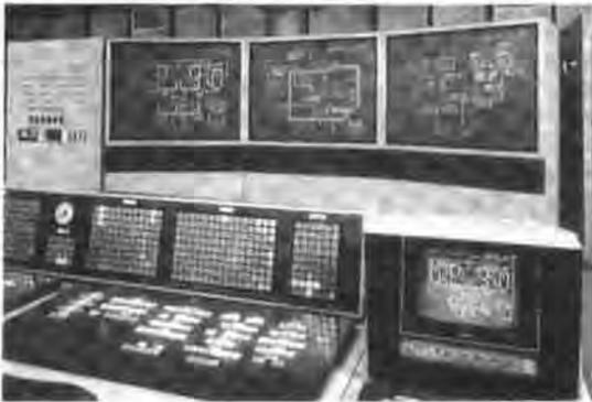
写真9-8 内蔵ビデオプロジェクターのグラフィック画面（砂町水処理センター旧汚泥棟監視室）
