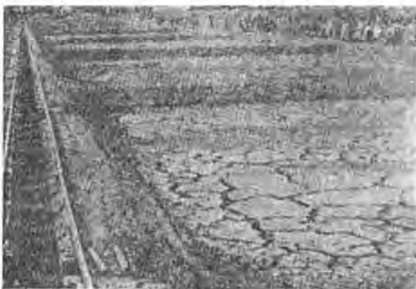
写真5-2 汚泥乾燥床（芝浦）
