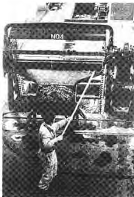
写真1-4 翼車回転式ろ格機
