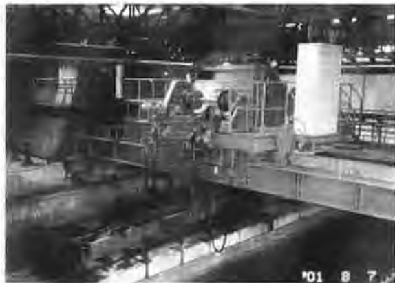
写真1-2 起伏腕式バケットエレベーター
