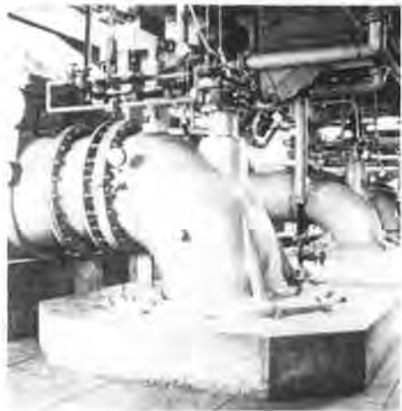
写真2-4 立軸斜流ポンプの例
